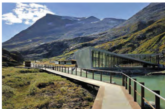
Foto: Jarle Wæhler/Statens vegvesen
